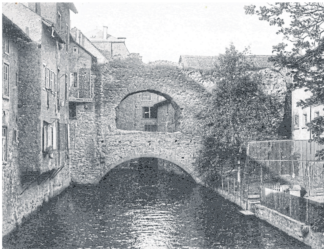
Das Wassertor (→17), um 1910. Links die Stadtmauer in der Mühlenstraße.
